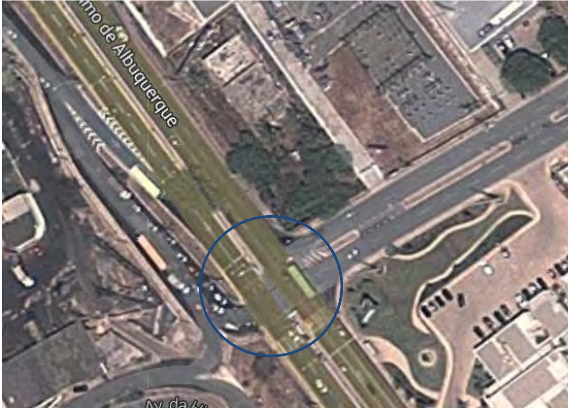
Figura 1 - Cruzamento na Avenida Jerônimo de Albuquerque
